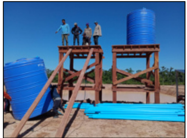
貯水タンク設置
