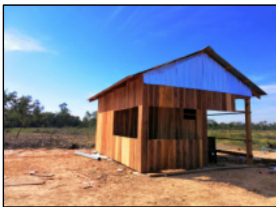
設備保管倉庫
