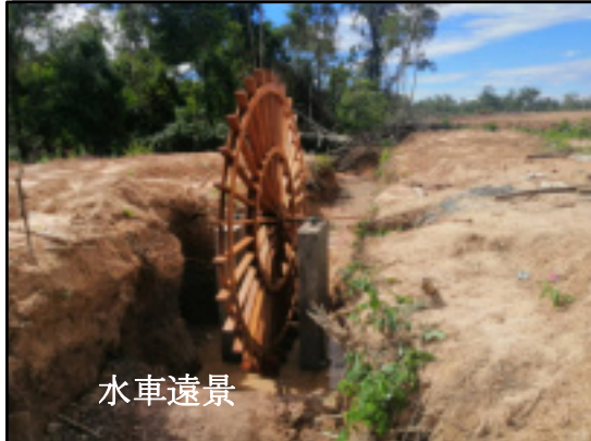
水車台基礎工事
