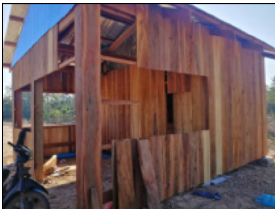
設備保管倉庫
